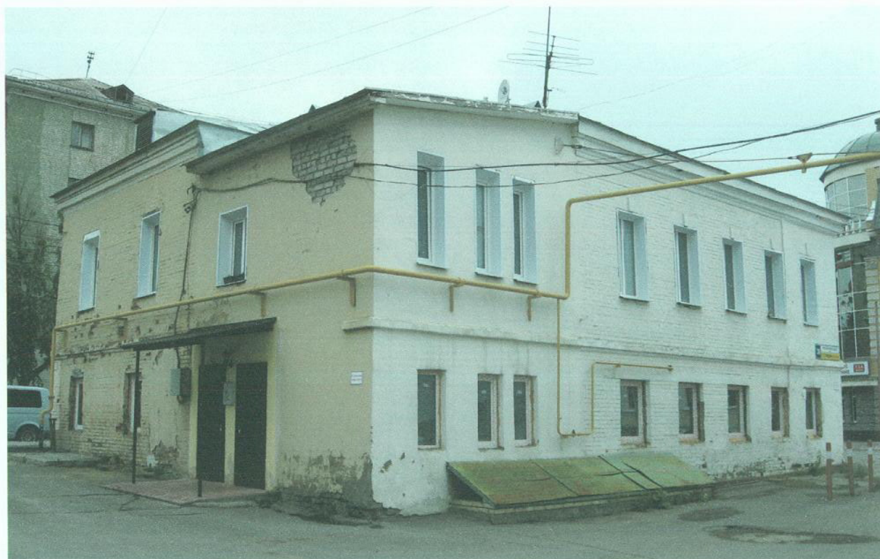
Фото 4. Вид со двора, с юго-востока.
