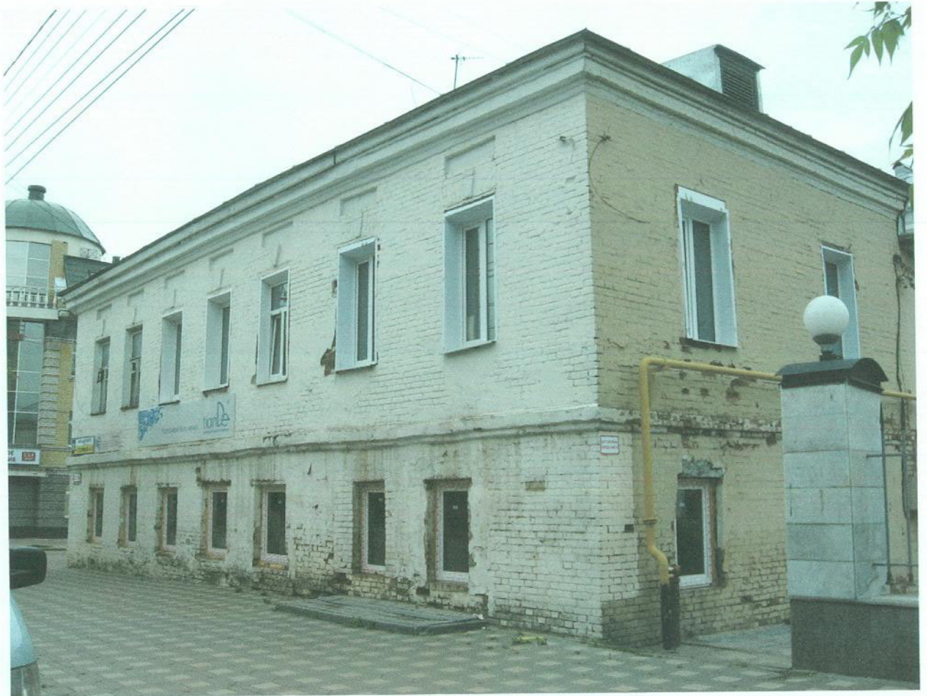
Фото 5. Западный фасад (по улице Володарского).
